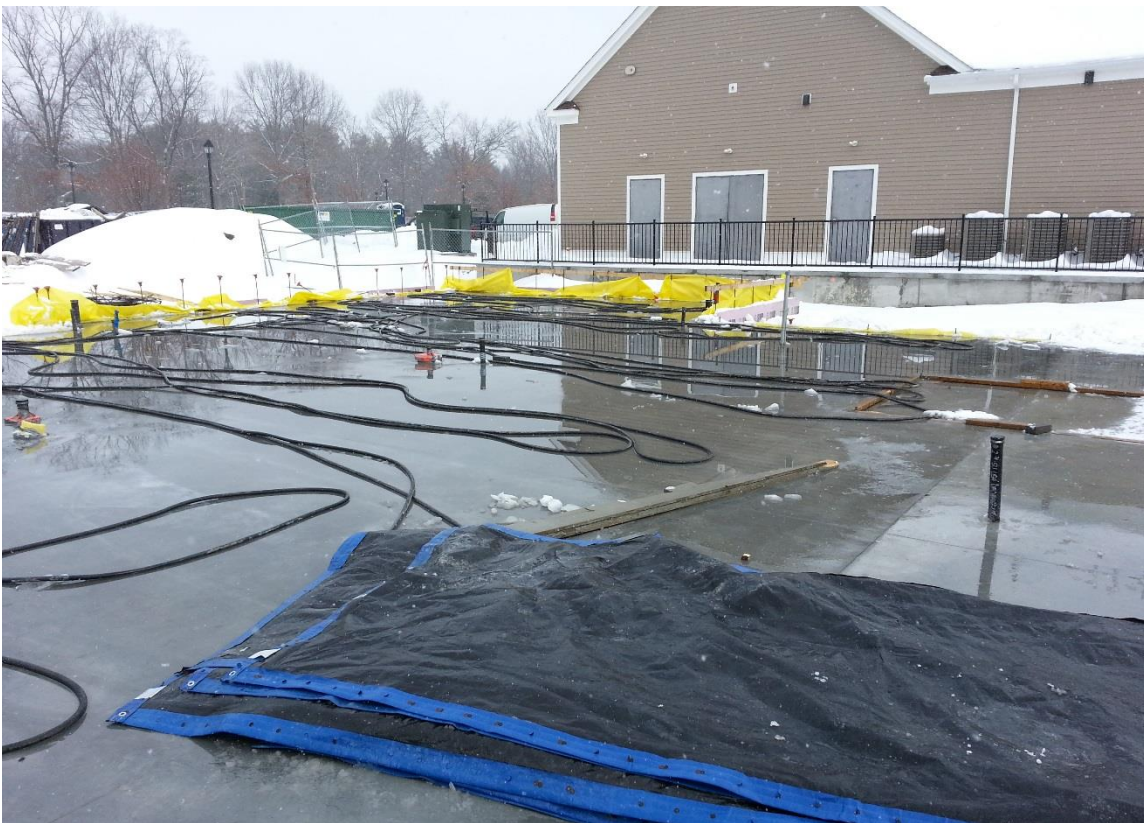
FINAL SLAB POUR SHOWING CURING METHODS 2-3-16
